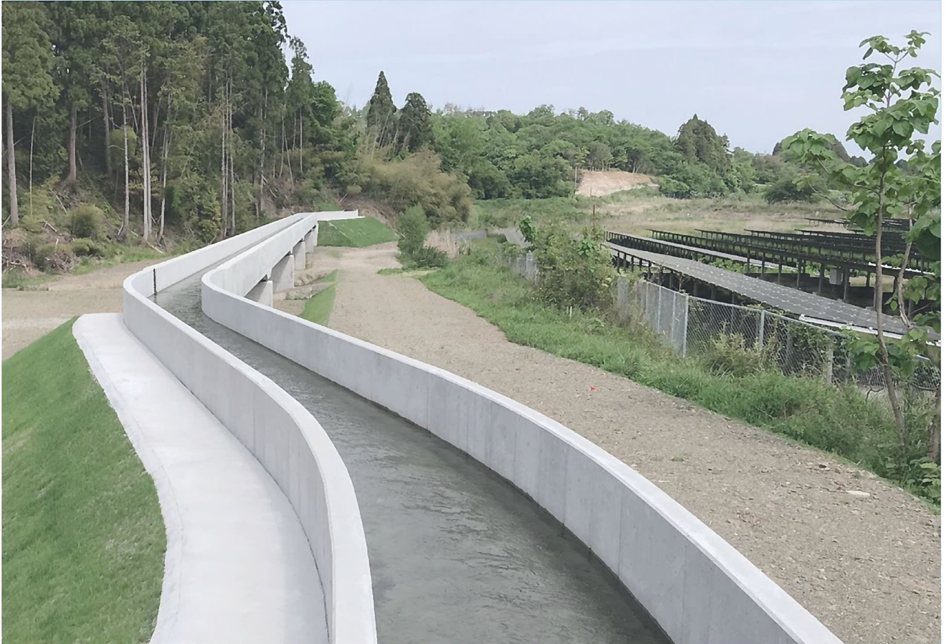
左岸幹線用水路 水路橋 (安曇川町下古賀地先)
