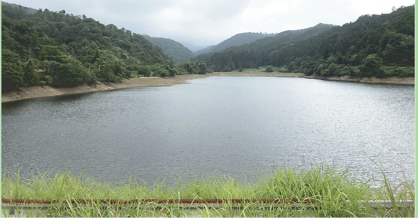
奥山ダム (令和元年7月撮影)
