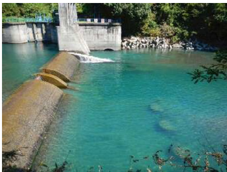
① 下流部工事前
