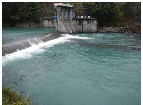
⑥ 下流 2 期工事完了
