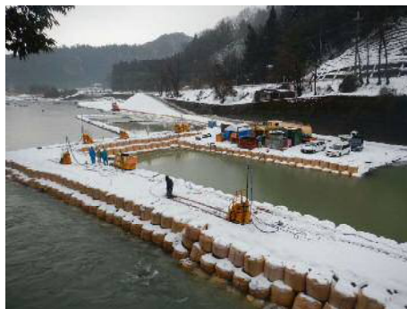
② 土のうによる締切と 薬液注入による止水
