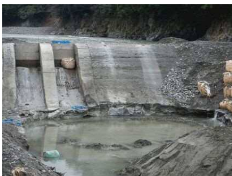
④ 固定堰底の空洞充填完了
