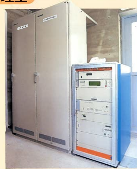
光端局装置・被遠隔監視制御装置
