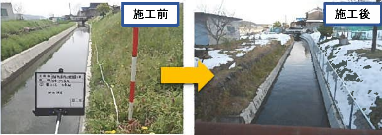
転落防止柵設置 L=626.5m
