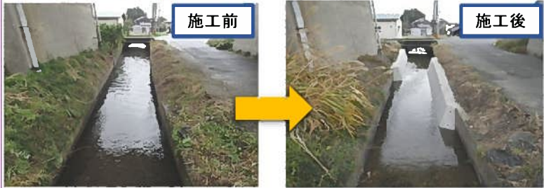
水路壁補修 L=15.4m
