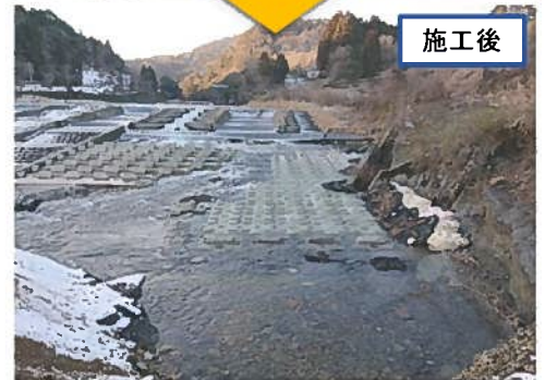
袋詰玉石(3t)132個、消波根固めブロック(3t)58個設置
