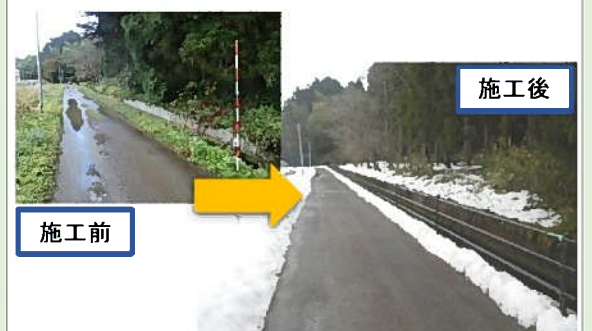
転落防止柵設置 L=113.7m
